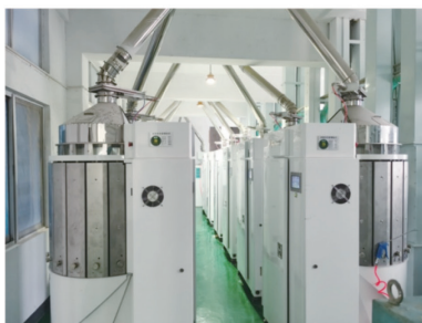
大米车间应用现场之一
